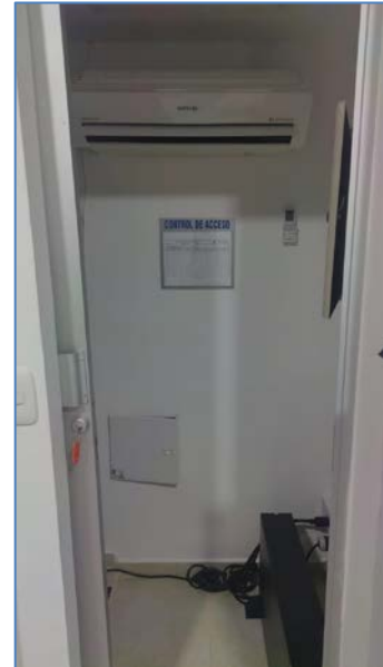
Ilustración 1. Ingreso cuarto técnico
